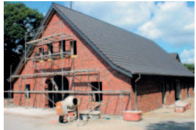
Landwirtschaftliches Betriebsgebäude vor und während der Umbauphase
