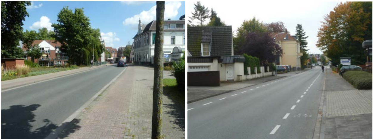
Abbildung 61: Markierung von Schutzstreifen (Beispiel Ahauser Straße)
