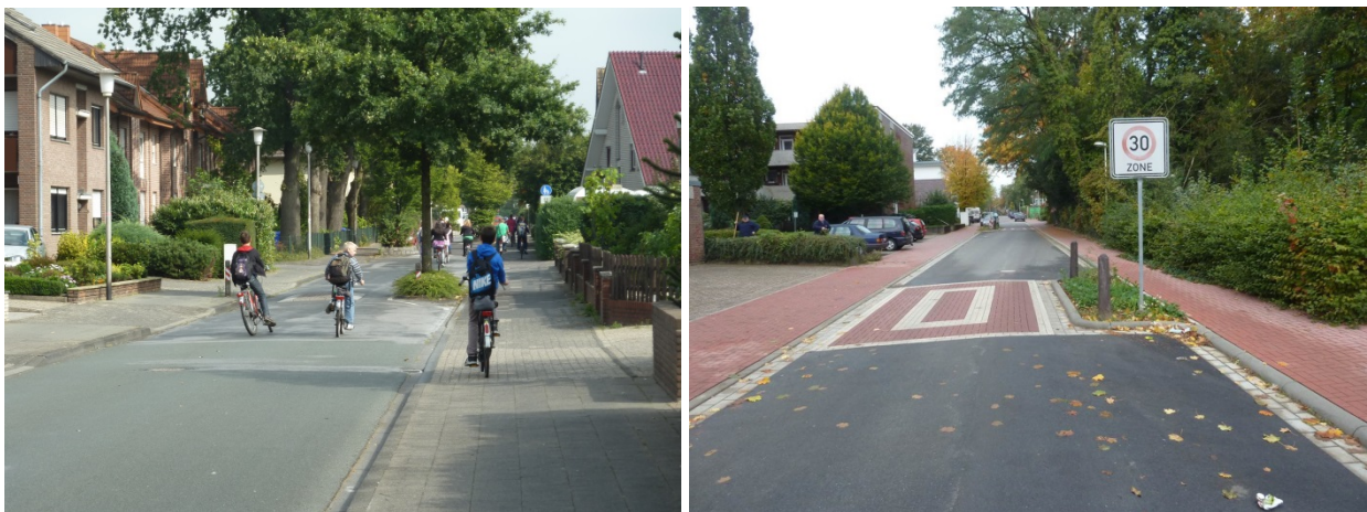
Links: Führung des Radverkehrs im Mischverkehr; rechts: Baumtor zur Reduzierung des Geschwindigkeitsniveaus; Quelle: eigene Aufnahmen
