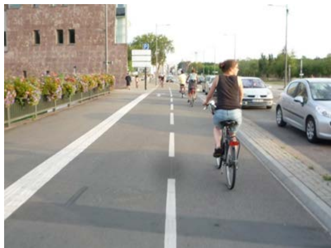
Abbildung 58: Radbahn in Straßburg mit baulicher Trennung von Kfz-Fahrstreifen
