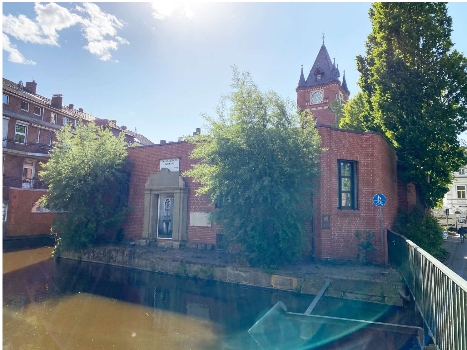
Rückseite Bestandsgebäude an der Dinkel 2020
