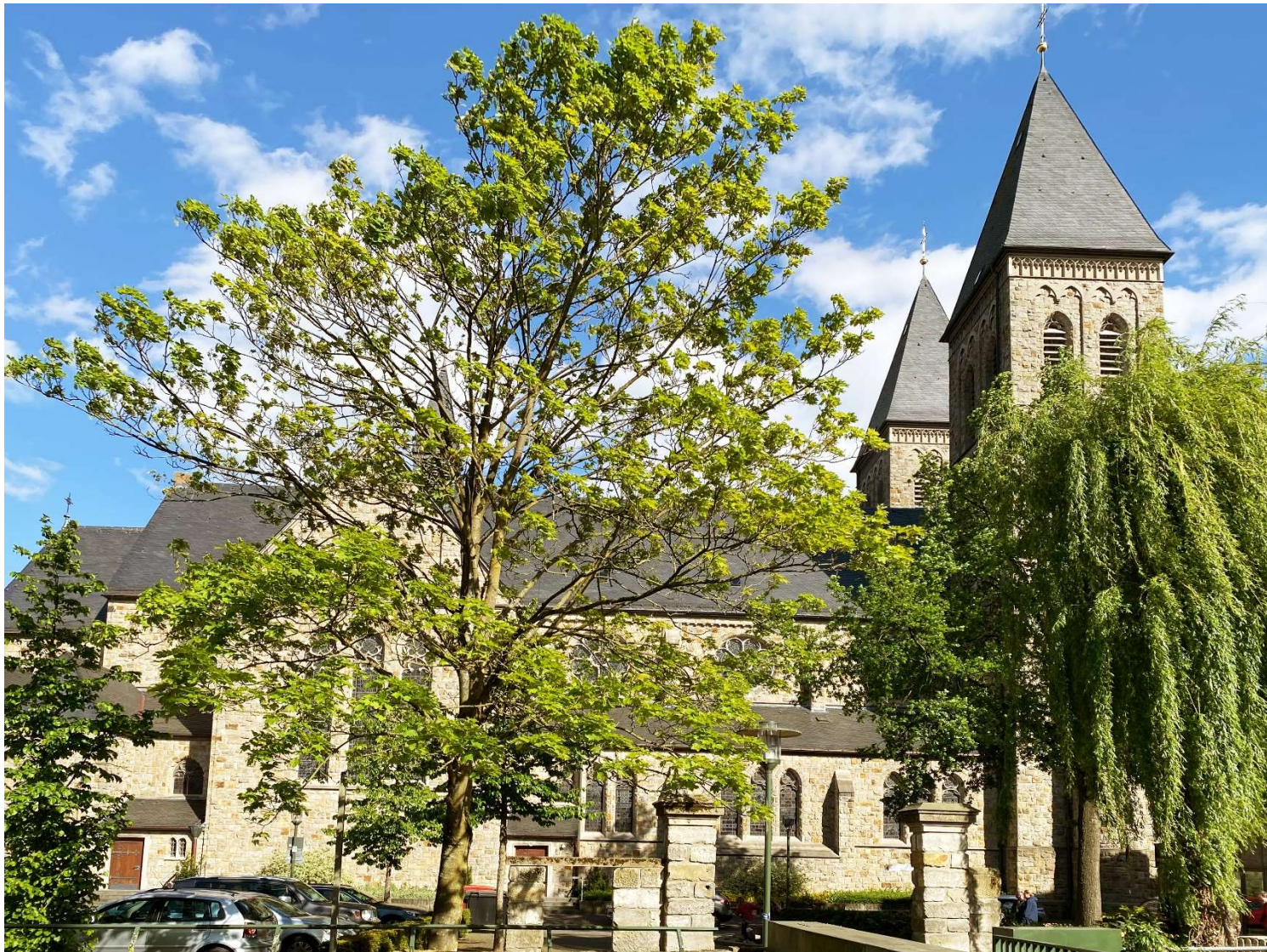
Blick vom Rathausgrundstück zur St. Antonius-Kirche 2020
