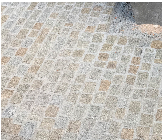
Mosaiksteinpfaster im Randbereich
