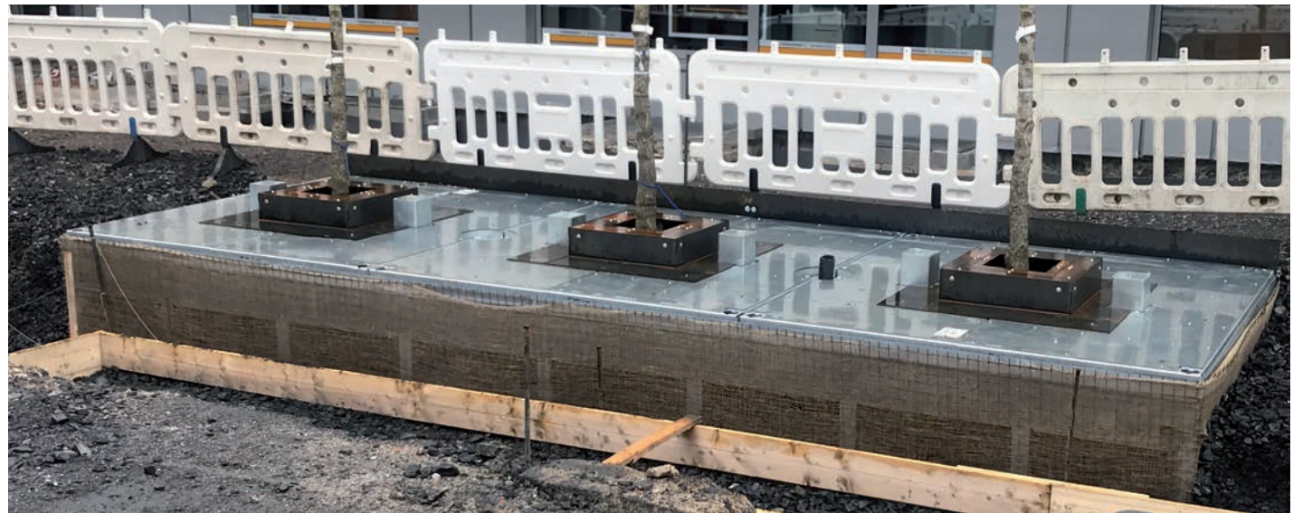
Unterflurbaumrost überpflasterbar mit integriertem Bewässerungssystem (Fa. Humberg)
