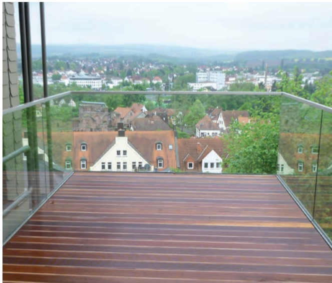
Bsp. Absturzsicherung aus Glas
