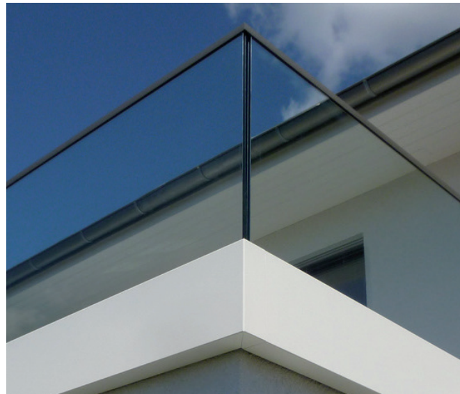
Bsp. Absturzsicherung mit Verkleidung aus Stahl
