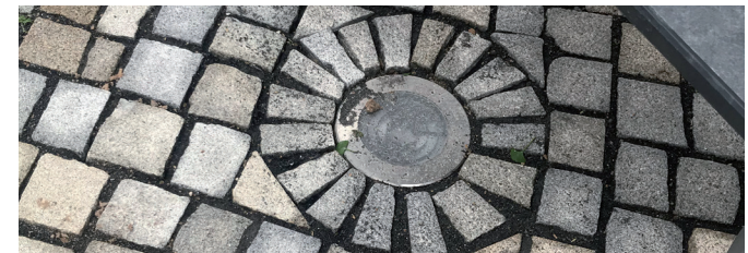
Bodenstrahler im Pflaster
