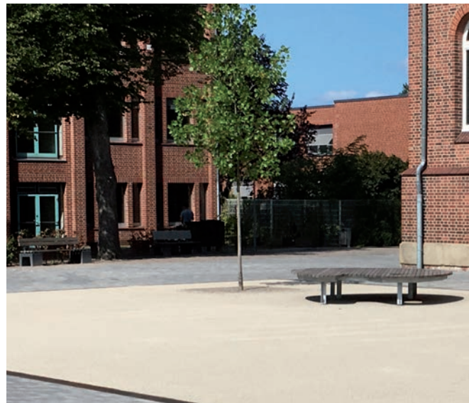
Asphaltbelag mit kunstharzgebundener Natursteinsplittabstreuung
