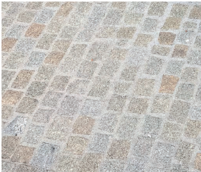
Mosaiksteinplaster im Randbereich
