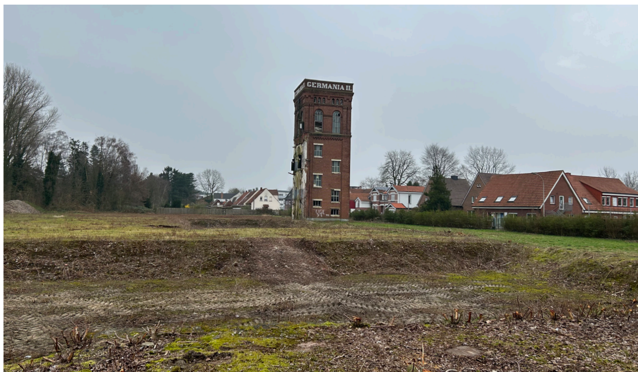
Abb. 33 | Überbleibsel des Brandes im Werk II
