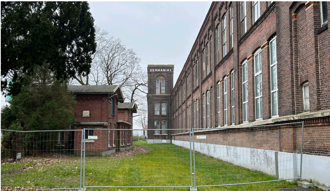
Abb. 22 | Spinnereigebäude mit Turm und Pförtnerhaus
