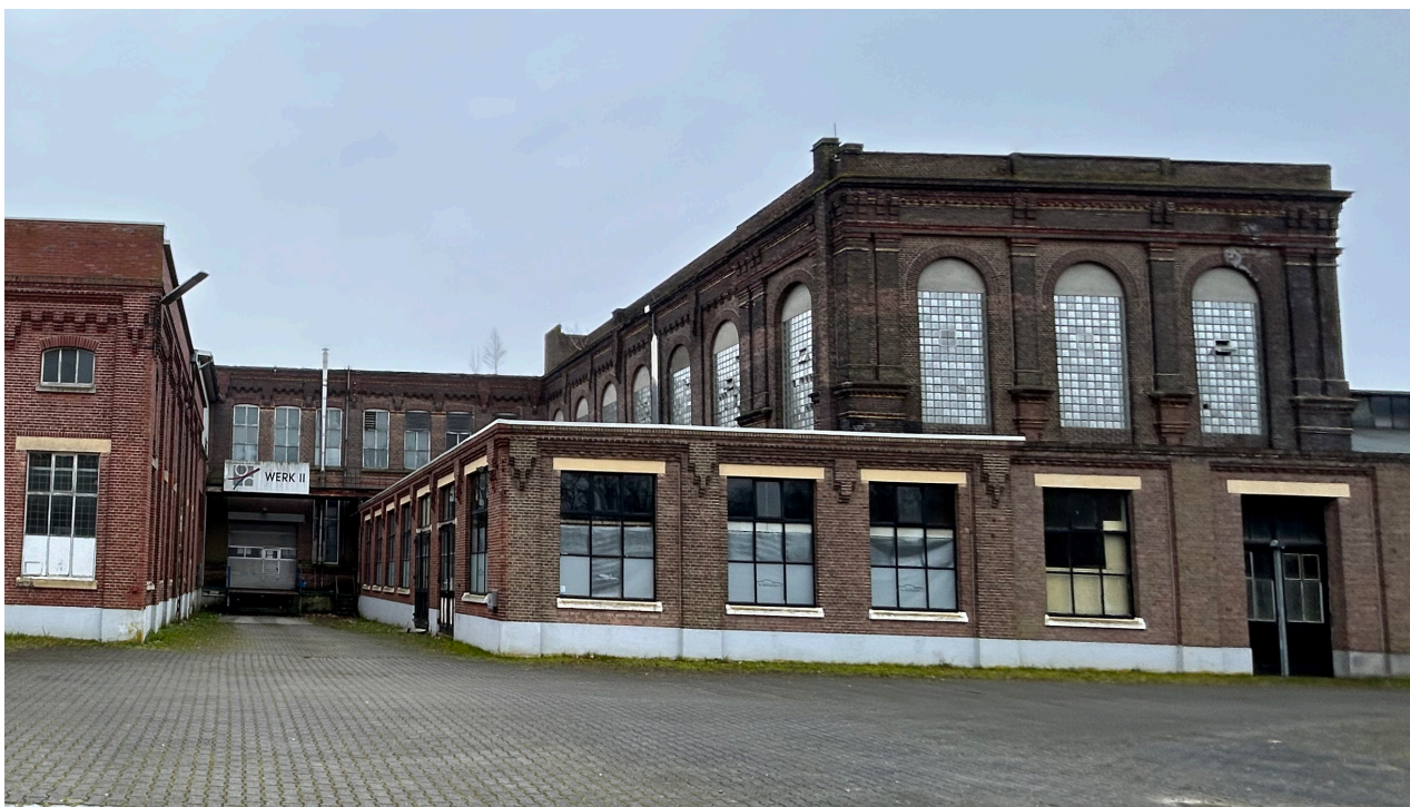
Abb. 23 | Bislang „eingebaute“ Maschinenhalle
