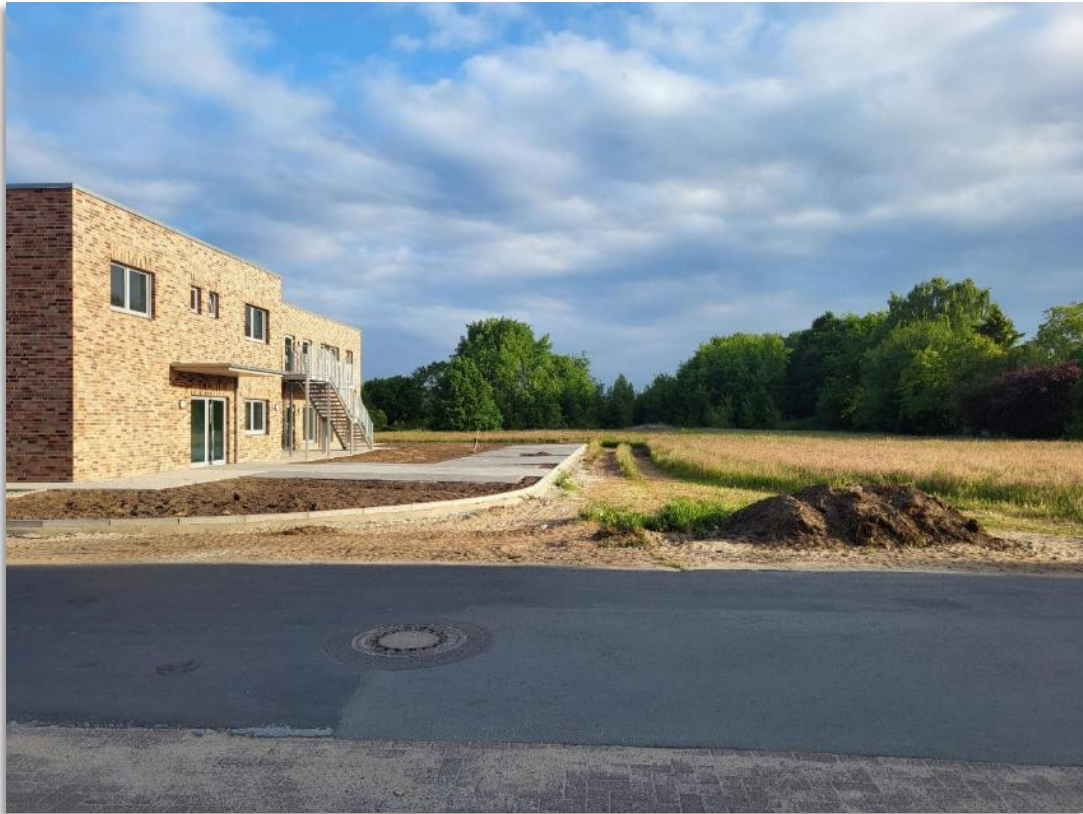
Blick nach Norden auf die Freifläche und den Neubau der Kindertagesstätte
