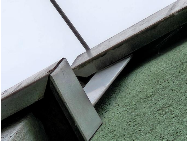
Abb. 7: Metallverkleidung an oberer Dachkante
