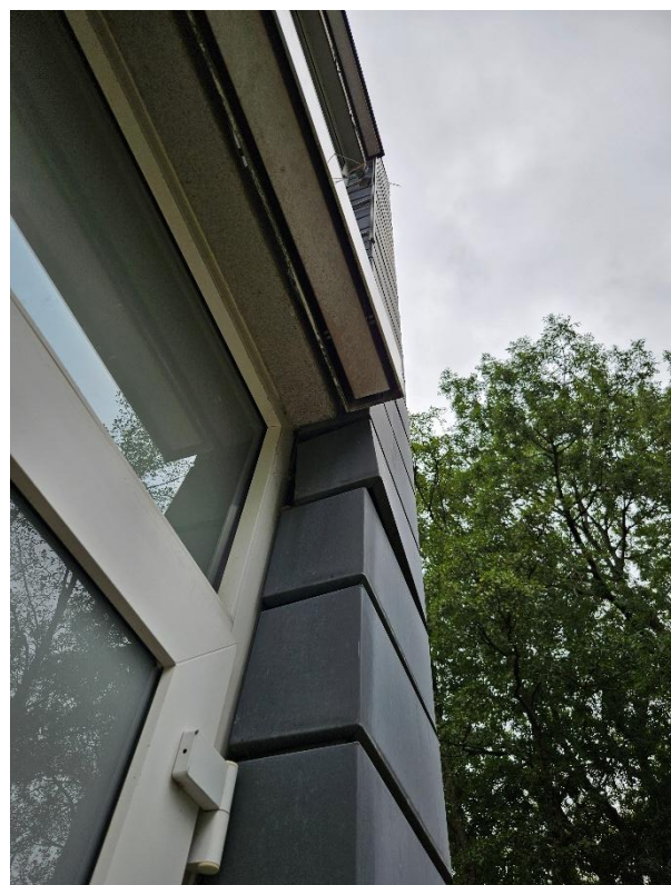
Abb. 6: Einschlupfmöglichkeit unter Metallverkleidung
