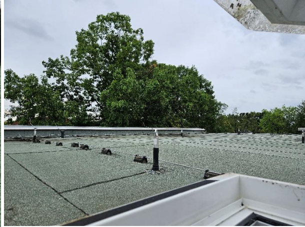
Abb. 8: Blick auf das Dach
