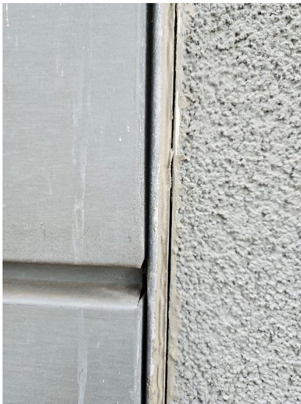
Abb. 5: eng anliegende Metallverkleidung
