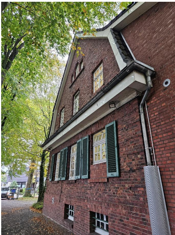
Abb. 1: Ansicht Südostseite KiTa
