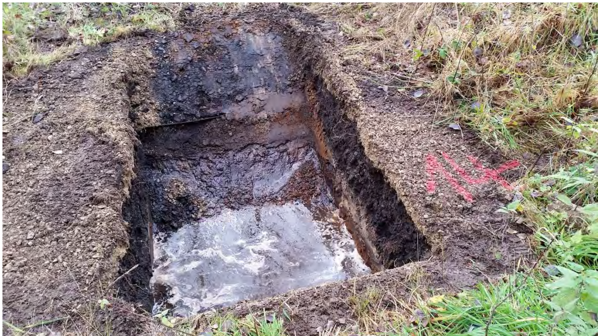
Gesamtansicht des Schurfes
