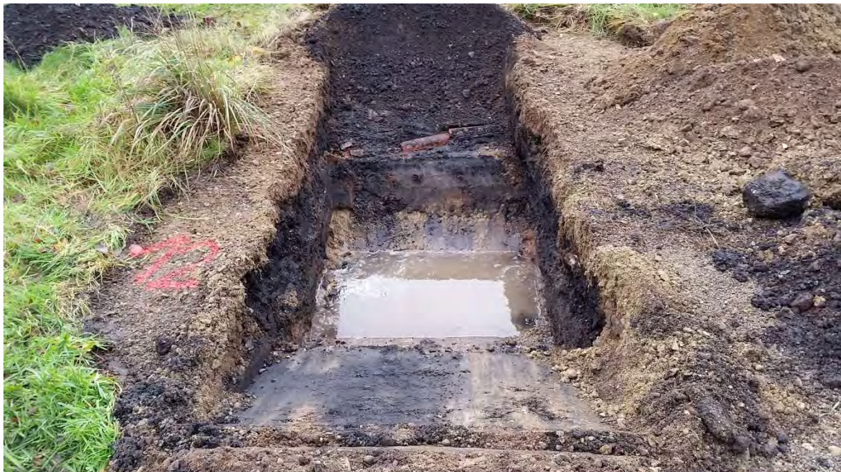
Gesamtansicht des Schurfes
