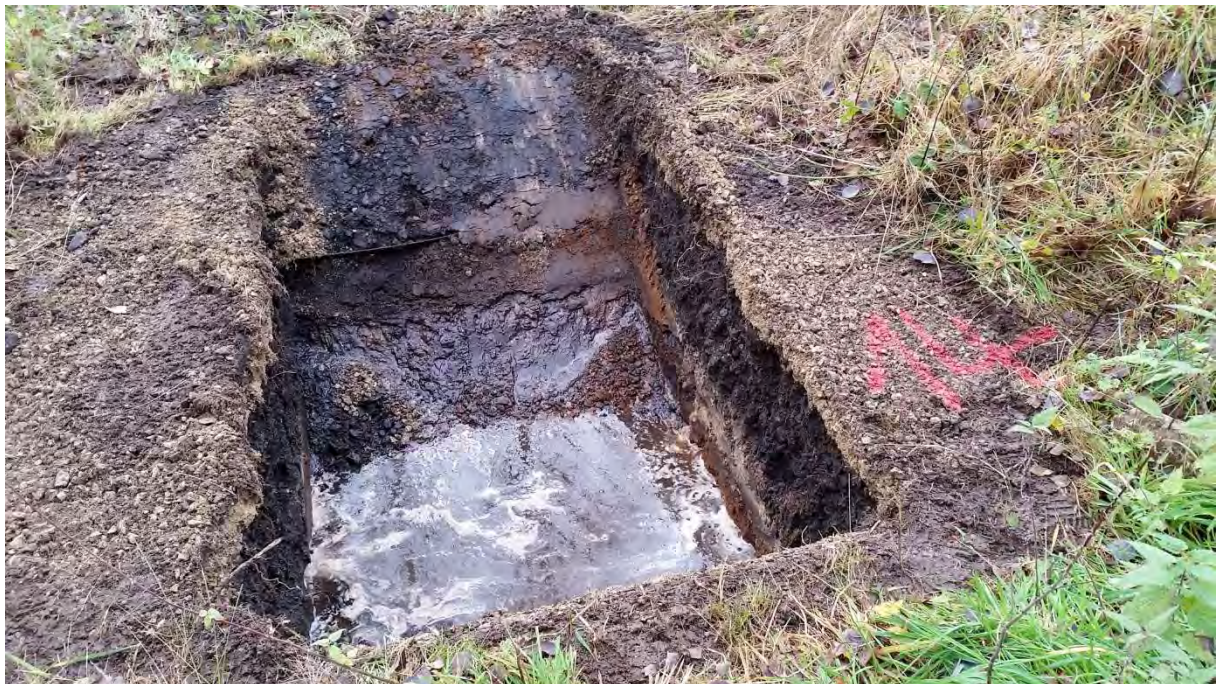
Gesamtansicht des Schurfes
