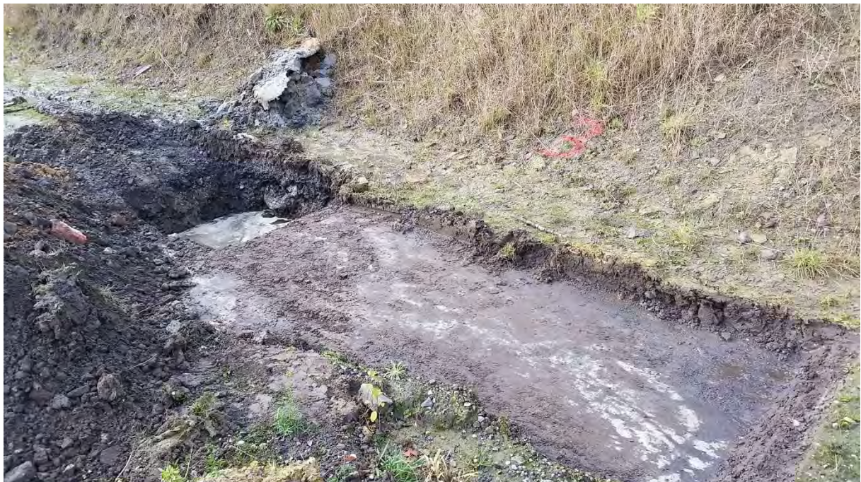
Gesamtansicht des Schurfes
