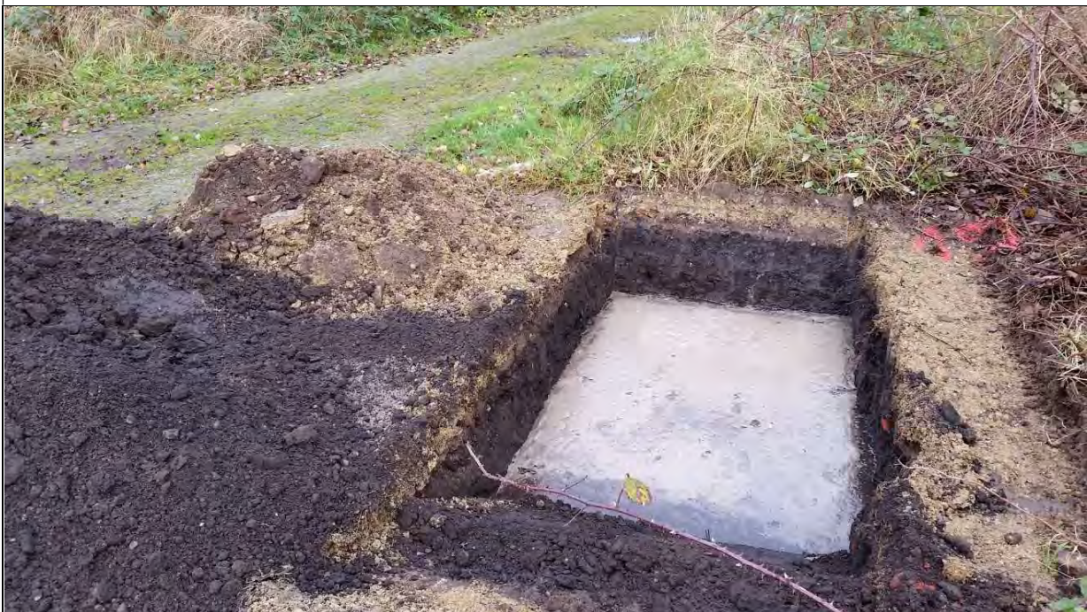
Gesamtansicht des Schurfes
