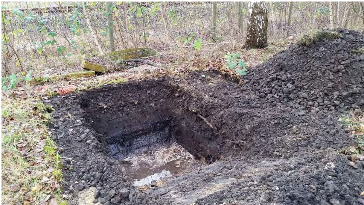
Gesamtansicht des Schurfes
