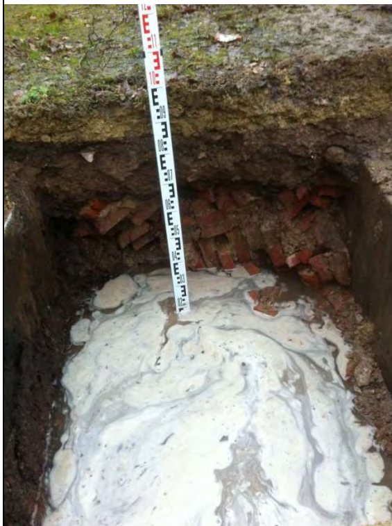
Schichtenabfolge des Schurfes bis zur Wasseroberfläche
