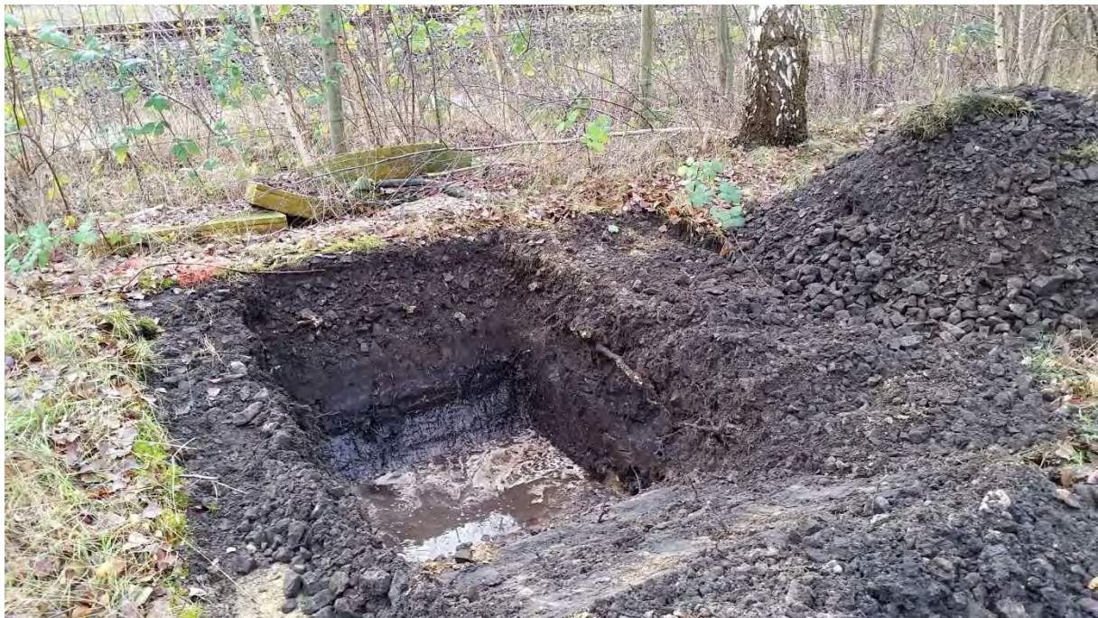
Gesamtansicht des Schurfes
