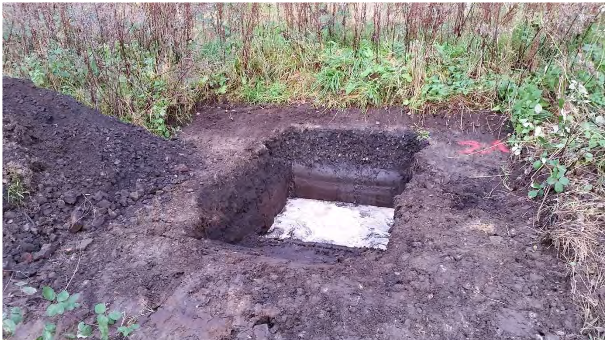
Gesamtansicht des Schurfes
