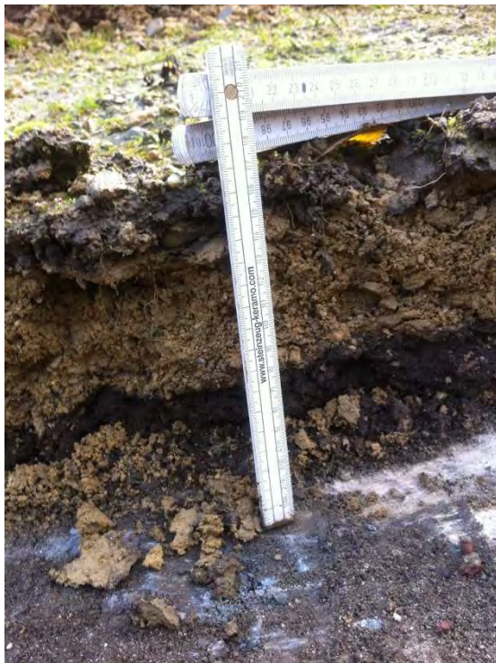
Nahaufnahme der Schichten und der Betonplatte
