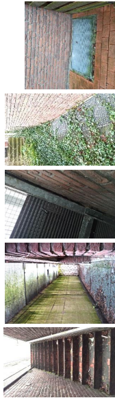
Foto 63 bis 67: Kellererengang, Kellerlichtschächte, Lichtgitter verschließen die Kellerräume zuverlässig
