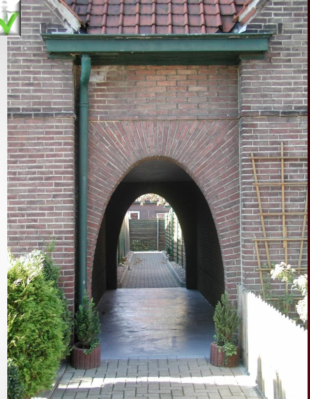
Überbauter Durchgang innerhalb einer Häuserzeile
