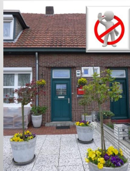
Nicht denkmalverträgliche Pflasterung
