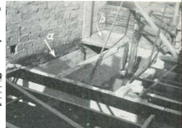
Fußbodenlager für den Erdgeschossfußboden. Tiefkeller (a) unter dem Treppenauf. b) Betonplatte
