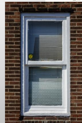
Küchenfenster giebelseitig, Haustyp II (siehe Foto oben und links)
