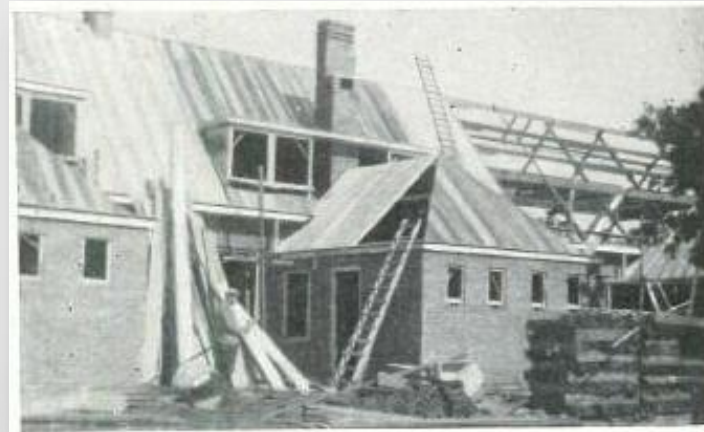
Anordnung der Dachschalung quer zur Pfettenlage
