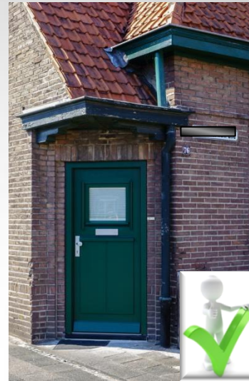
Haupteingangstüren Typ II (s. Fotos oben)
