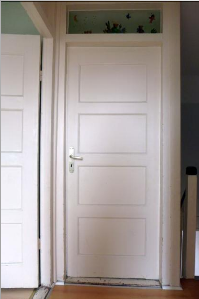
Zimmertür im OG mit Oberlicht
